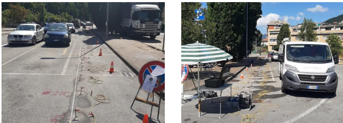
Figura 242. Foto indagine ERT sottostazione di "Prato".
