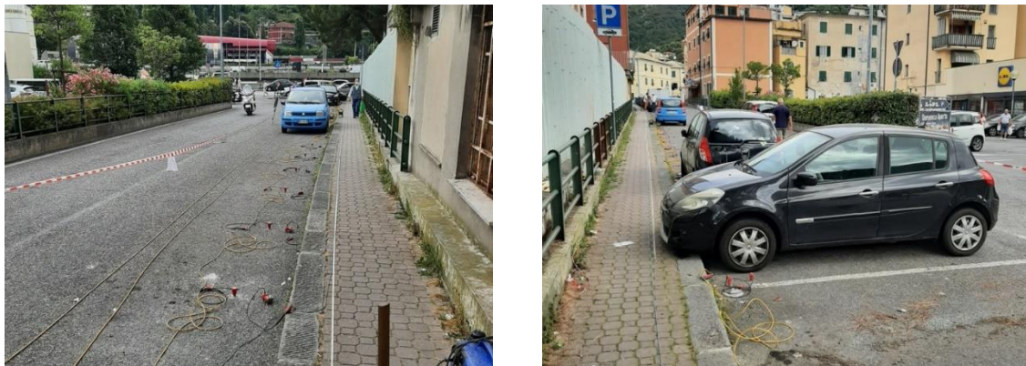
Figura 272. Foto indagine SRT sottostazione di "Gottardo".
