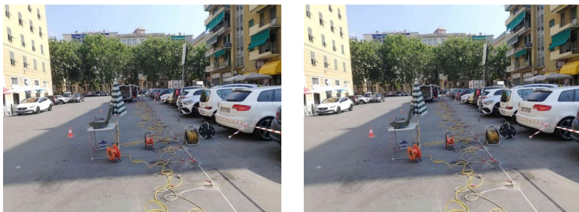
Figura 326. Foto indagine SRT sottostazione di "Sardegna".
