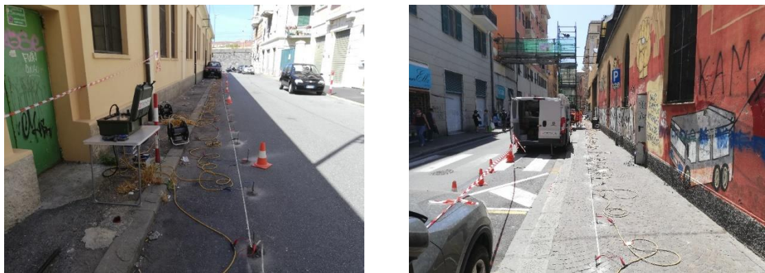
Figura 86. Foto indagini ERT deposito di "Sampierdarena".
