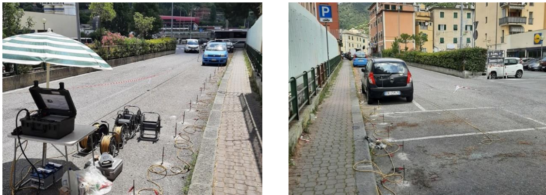
Figura 236. Foto indagine ERT sottostazione di "Gottardo".
