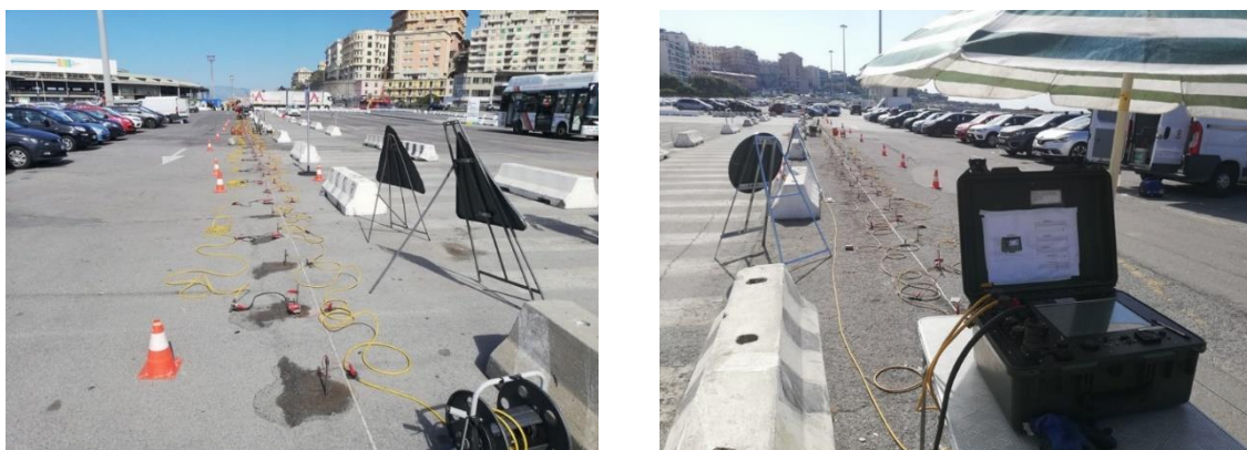
Figura 314. Foto indagine SRT sottostazione di "Kennedy".
