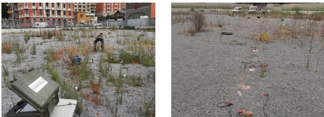
Figura 308. Foto indagine SRT sottostazione di "via Merano".
